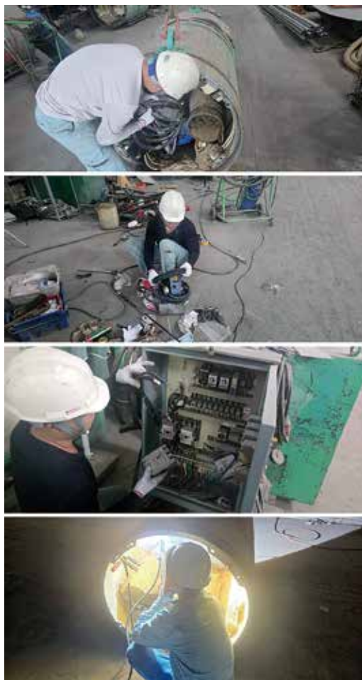
写真-3 ベトナム人社員による掘進機整備状況
