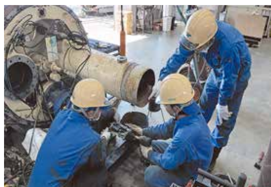
写真-17 電動機のベアリング交換
