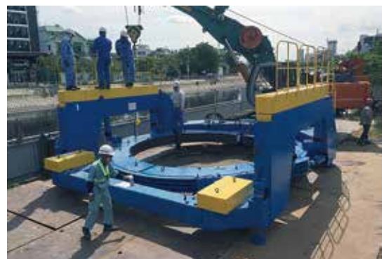
写真-15 ケーシング立坑構築機
