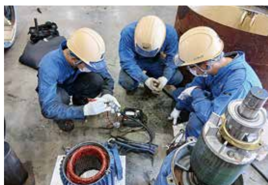
写真-18 電動機、絶縁抵抗検査を実施
