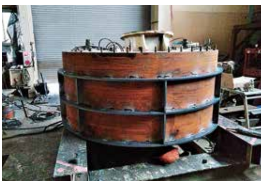
写真-13 外周部補強リブ溶接、拡幅改造作業
