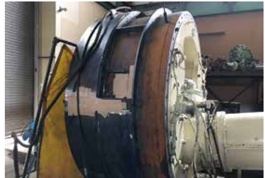
写真-14 外周部に巻板溶接
